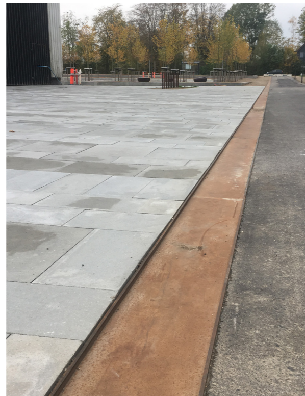
En åben rende i cortenstål leder regnvand mod en større lokal plads; pladsen fungerer som forsinkelsesbassin ved skybrud.
