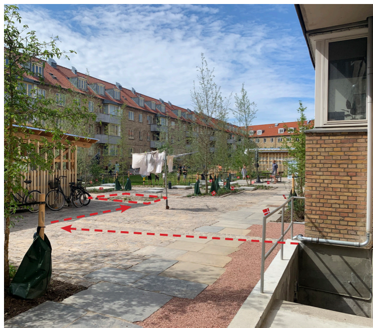
Men fodbøjning ledes regnvandet til en åben rende i belægningen og videre til et regnbede og græsarealer. (Se de røde stiblinger der indikerer vandets vej)
