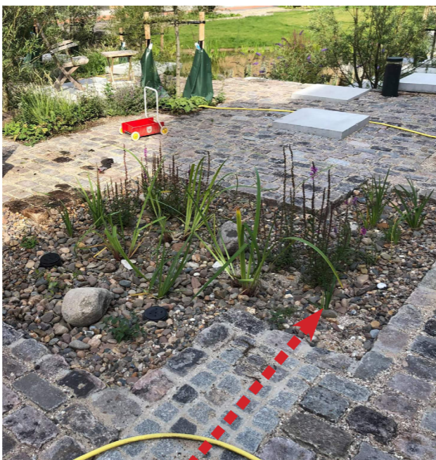
Men fodbøjning ledes regnvandet til en åben rende i belægningen og videre til et regnbede og græsarealer. (Se de røde stiblinger der indikerer vandets vej)
