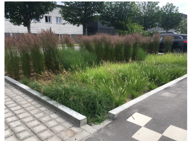
Regnvand der falder på parkeringsarealer (fx fliser) og vejarealer (asfalt) ledes til regnbede. Her renses regnvandet gennem ned-sivning i filtermuld inden det drosles til recipient.
