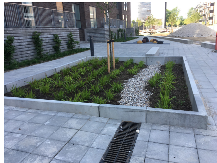
Her ledes regnvandet via et linjedræn til et plantebed hvor regnvandet bidrager til vanding af træer og beplantning.
