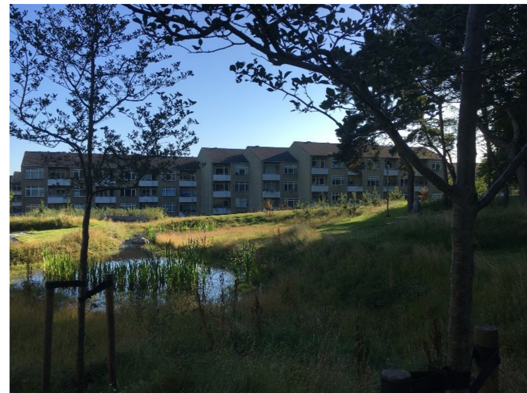
Regnvandsopsamlingen i Kildeparken skaber rolige og smukke naturlige omgivelser. Området har tidligere bestået af store grønne klippede plæner. Nu fremstår det med varieret udtryk, forskellige grøfter og regnvandsbassiner tegner områdets landskabelige karakter til glæde for både børn, voksne samt dyre- og planteliv.
