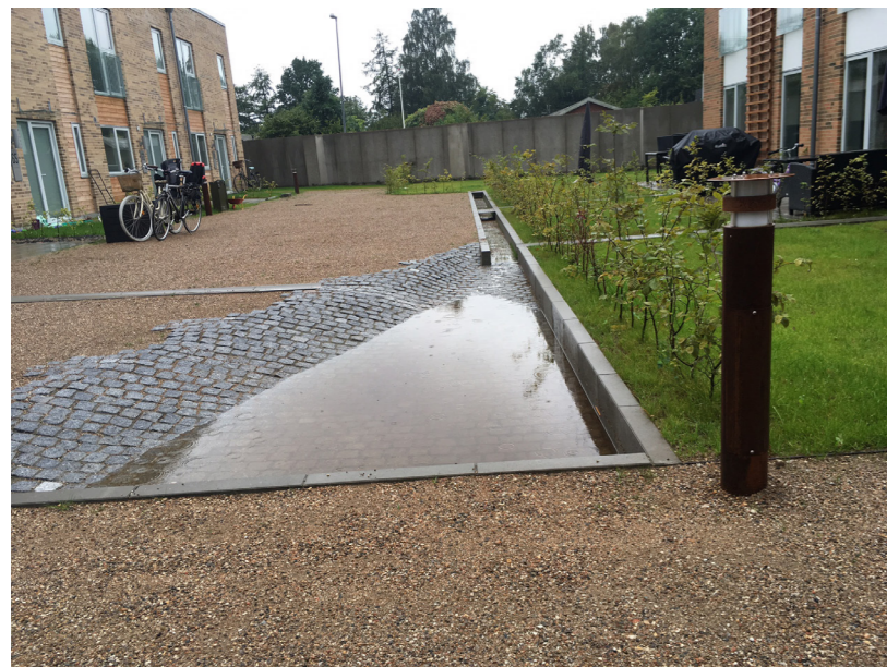
Regnvand fra hustage ledes til vandelement langs private haver. Efter regnskyl opstøver vandet i vandelementet hvor det forsinkes inden det løber til kloak.
