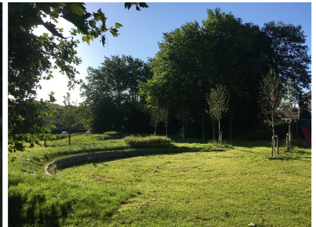
Herover ses en nedsænket græsplæne som anvendes som nedsivningsareal suppleret med en siddekanter. Hermed opnås dobbeltfunktion som er nødvendig i bymiljøer.
