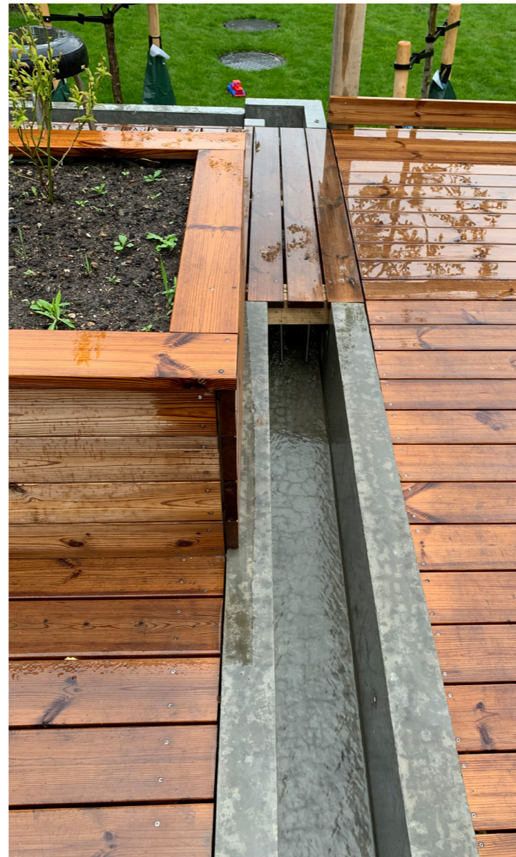
De nye regnvandsløsninger indarbejdes i elementer der danner ramme for ophold. Her en vandrede i stål, trædæk, en lille træ- 'bro' og siddekanter om plantebede.
